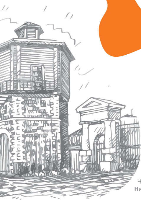
Водонапорная башня Екатеринбург
